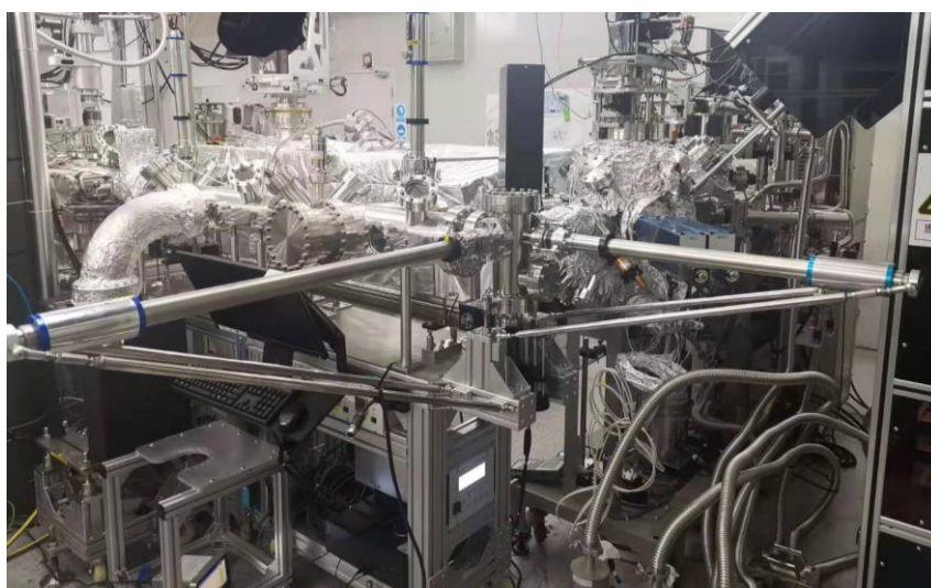
图 10 直线段实物照片
